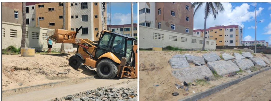
Figura 8 - Morador conduzindo o operador sobre a muretas de proteção
