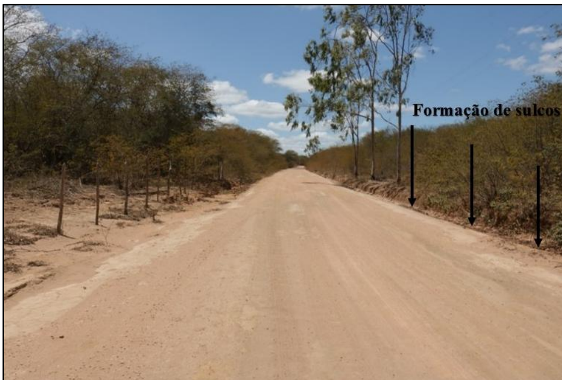
Figura 5 - Ação do escoamento superficial no topo
