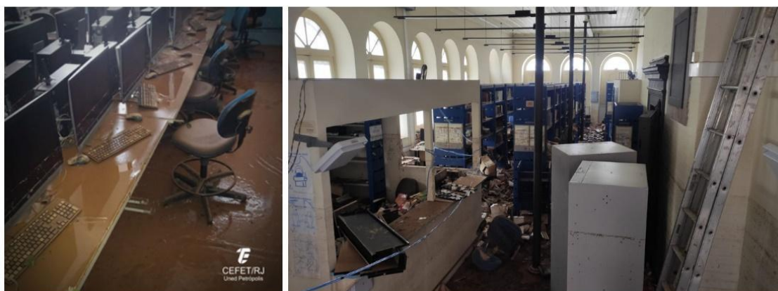
Figura 4 - Impacto dos desastres nas instalações do Cefet/RJ em Petrópolis após o desastre de fevereiro de 2022. Esquerda: laboratório de informática coberto de lama; Direita: biblioteca com o acervo destruído
